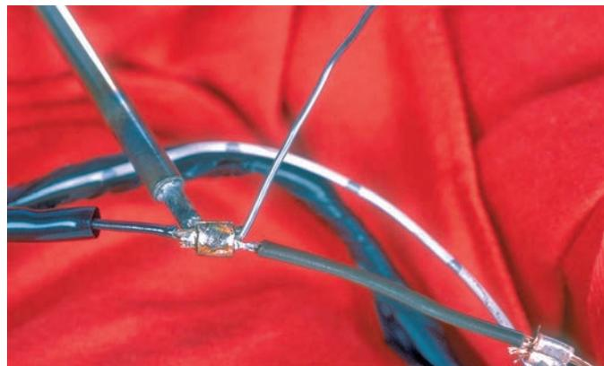
**P2-10** Chauffez le collier de jonction avec le fer à souder tout en appliquant de la soudure sur l'une de ses ouvertures. N'appliquez pas de soudure directement sur le fer à souder.
