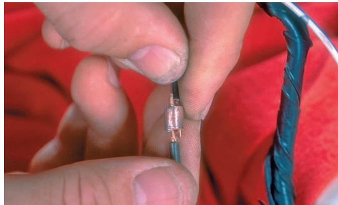
**P2-8** Juxtaposez les extrémités dénudées du fil existant et du fil de remplacement à l'intérieur du collier de jonction. Assurez-vous que les conducteurs dépassent légèrement le collier de jonction dans les deux sens.
